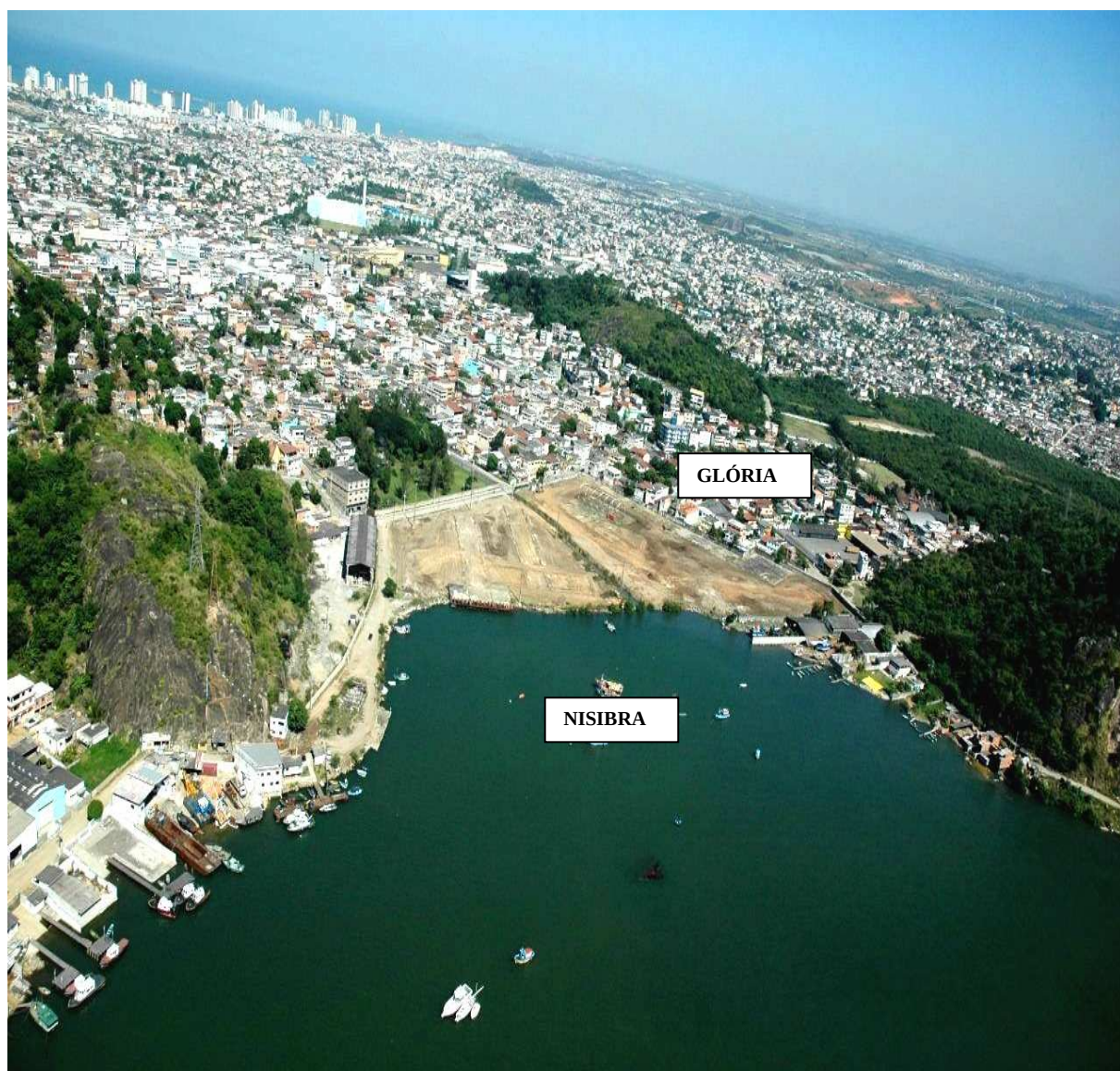
Ilustração 3.18 - Área da NISIBRA - Vista Frontal
